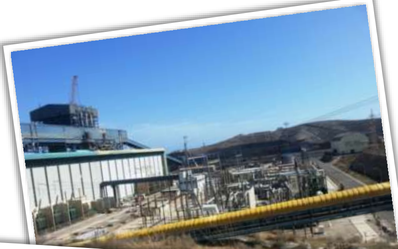
Power Plant (ENEL) Carboneras (Spagna)
