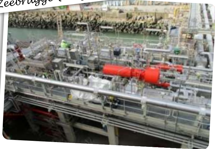
TS LNG BVBA (Techint/Sener) Zeebrugge (Belgio)
