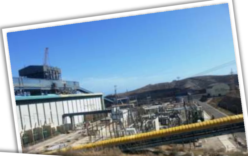
Power Plant (ENEL) Carboneras (Spagna)
