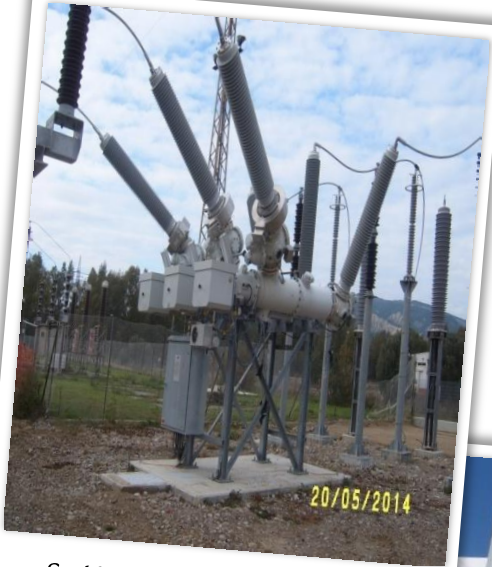
Sottostazione elettrica (Consorzio ASI) Pisticci (Italia)
