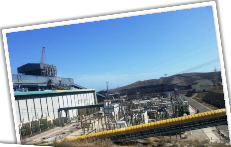
Power Plant (ENEL) Carboneras (Spagna)
