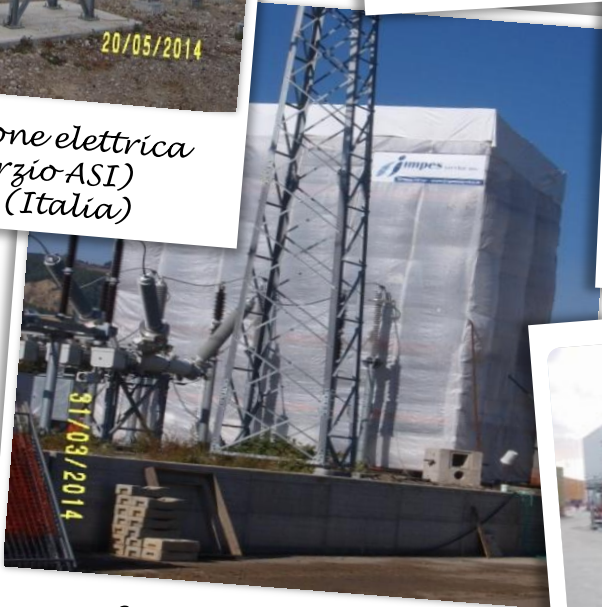
Sottostazione elettrica (Consorzio ASI) Pisticci (Italia)
